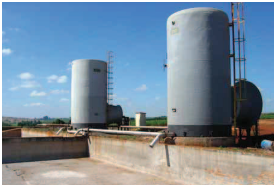
Figura 79 - Tanque em concreto para o recebimento e distribuição da vinhaça da destilaria equipado com duas torres de resfriamento de vinhaça, em uma usina.
