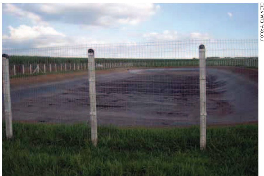
Figura 85 - Tanque de armazenamento de vinhaça impermeabilizado com geomembranas e protegido com cerca para evitar acesso de pessoas e animais.
