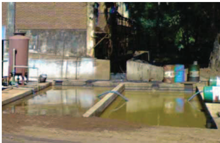
Figura 77 - Caixas separadoras de óleo (e areia) para tratamento do efluente da lavagem de veículos em uma usina.
