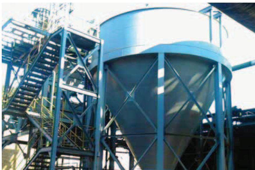
Figura 75 - Decantador de fuligem circular com fundo cônico em funcionamento em uma usina.
