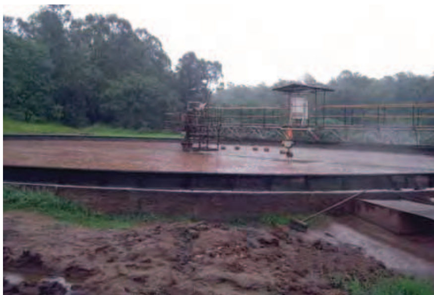
Figura 69 - Decantador circular de água de lavagem de cana modelo CTC em funcionamento em uma usina.
