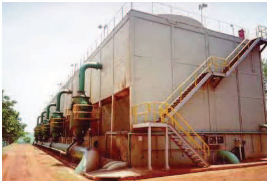
Figura 73 - Torres de arrefecimento (ou resfriamento) para o circuito de reúso da fábrica de açúcar.
