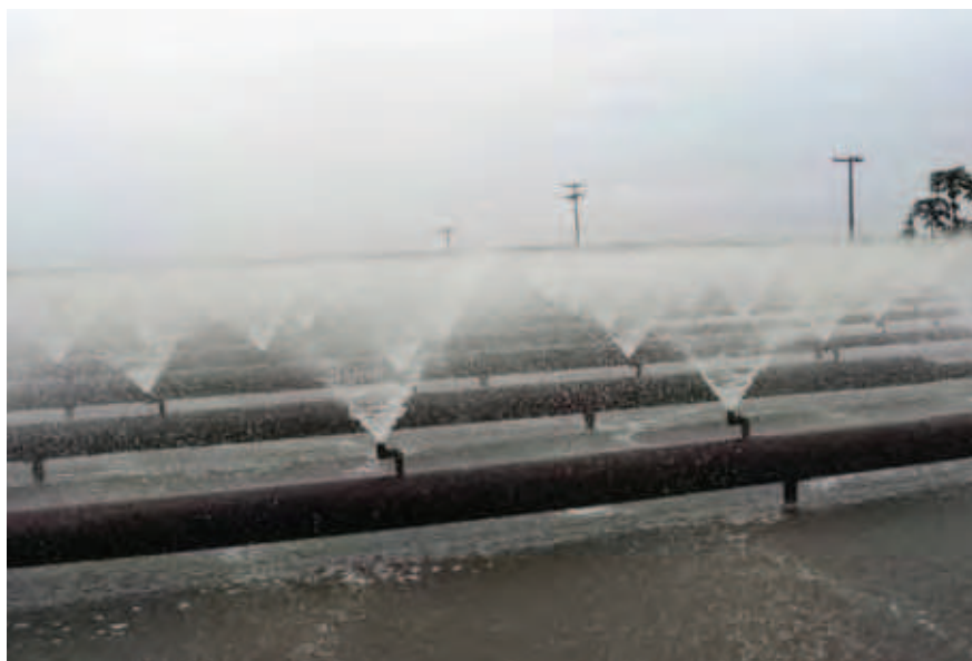
Figura 72 - Detalhe dos aspersores em tanques de resfriamento de efluentes para a fábrica de açúcar.
