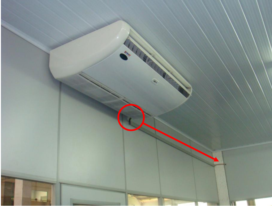
Foto 01 – Indica o caminho da tubulação criada.
